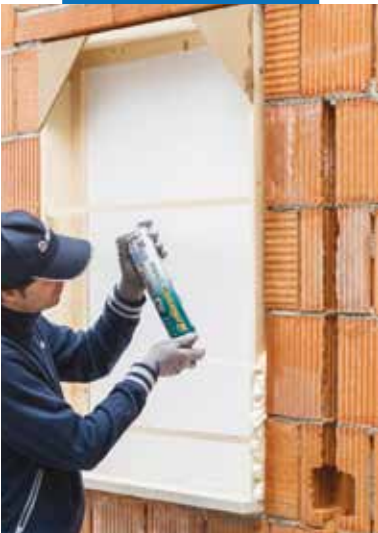
Заполнение зазора между оконной рамой и стеной
