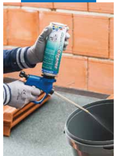
Очистка пистолета для пены
