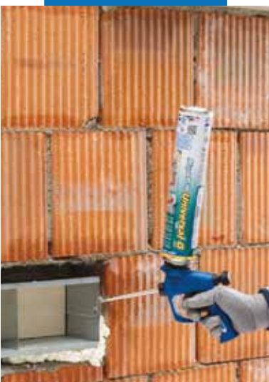
Заполнение вентиляционного канала
